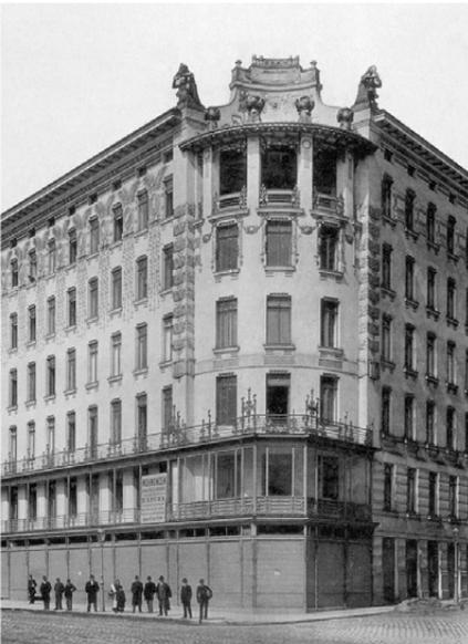
Las dos plantas inferiores se utilizan como base, con un forjado de hierro que comprende los espacios dedicados a las tiendas y que se extiende a los dos pisos superiores. La solución dada a la esquina con su redondez y las tres ventanas por planta, da una apariencia de una verdadera fachada y compensa el escaso relieve dado a los accesos.
