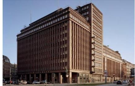
Gracias a la estructura de acero se permiten grandes luces en toda la profundidad del edificio, creando un diseño libre de los planos de planta de oficina y una perfecta adaptación a los estándares modernos.
